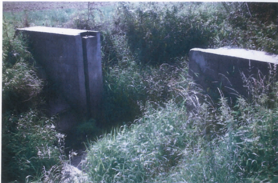
Dąbrocznia - zastawka w km 29+090
