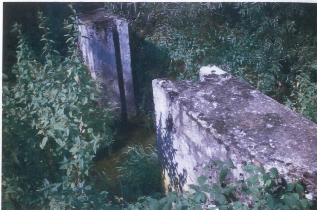
Dąbrocznia - zastawka w km 30+474
