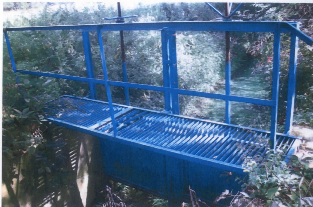
Dąbrocznia - zastawka w km 35+380
