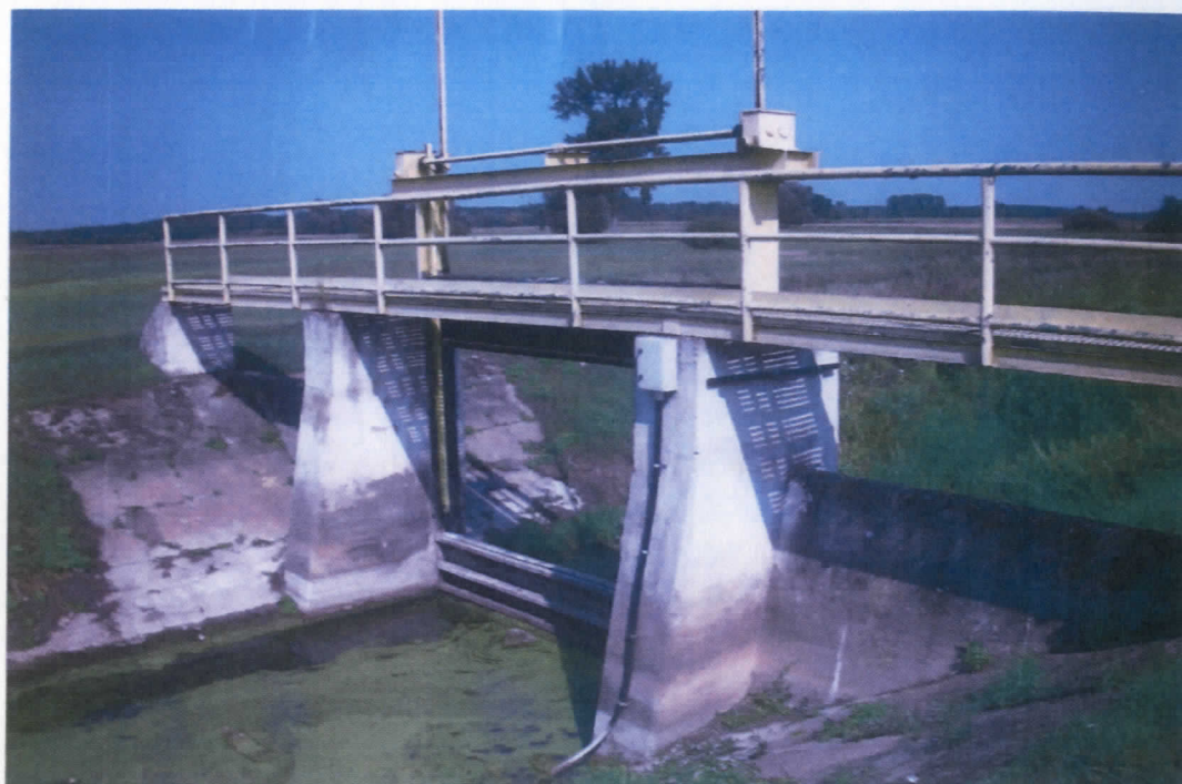
Dąbrocznia - jaz w km 1+700
