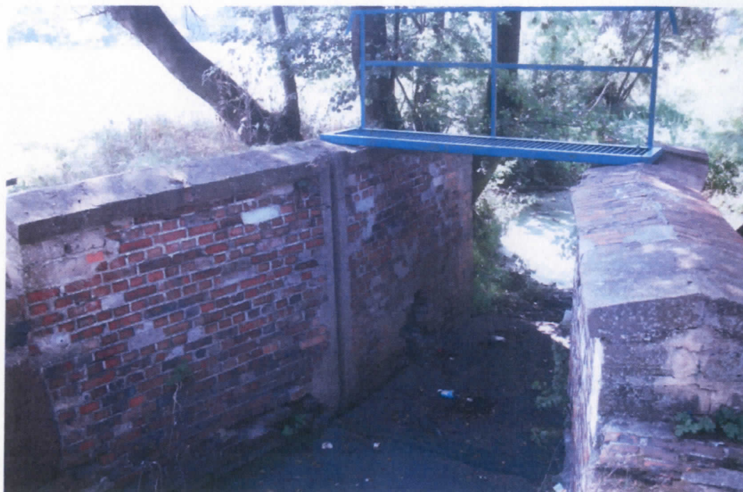
Dąbrocznia - zastawka w km 35+200
