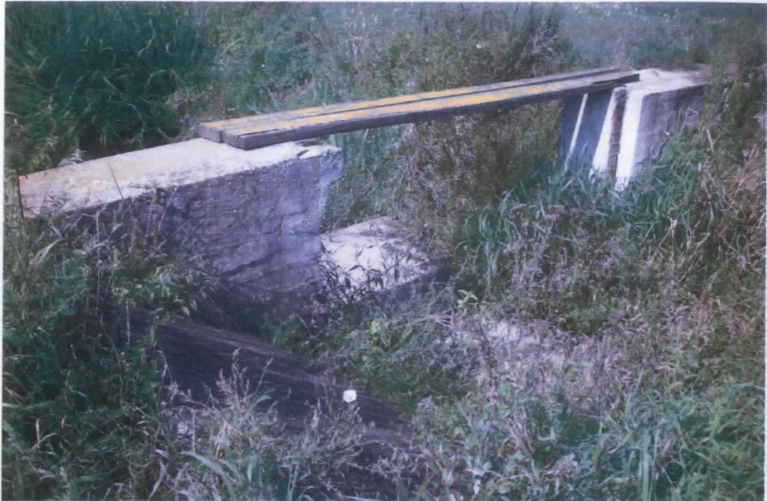
Dąbrocznia - zastawka w km 28+090
