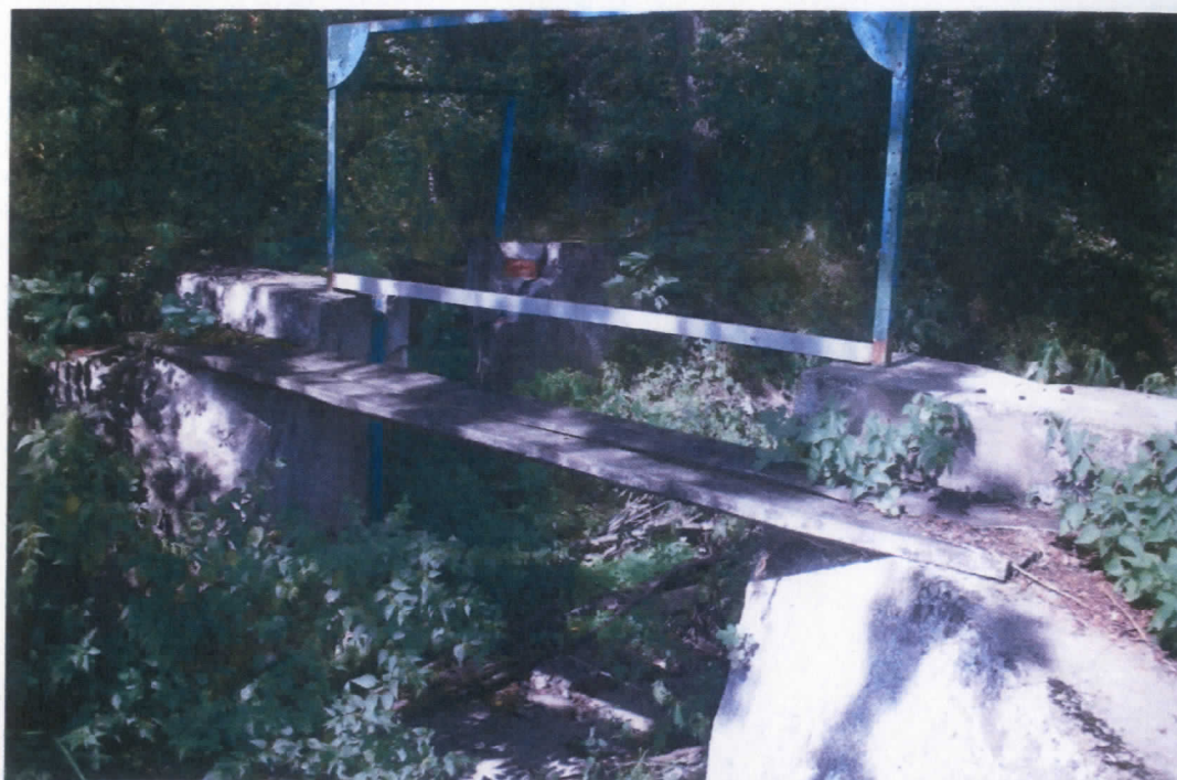
Dąbrocznia - zastawka w km 36+450
