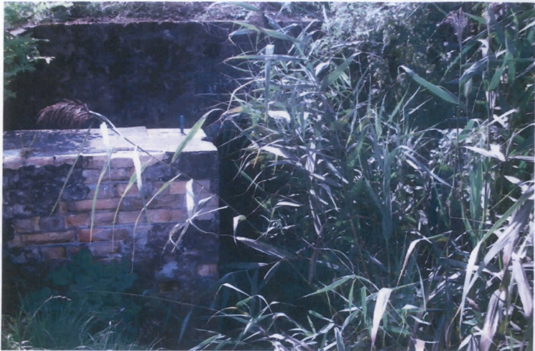
Dąbrocznia - zastawka w km 38+539
