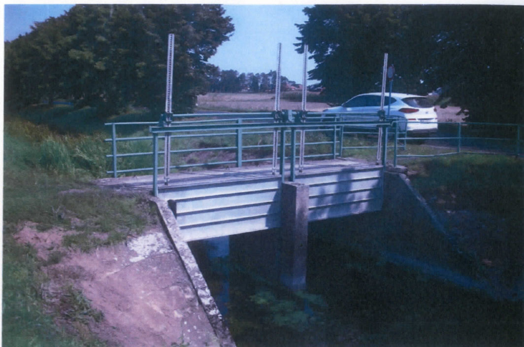
Dąbrocznia - jaz w km 14+340
