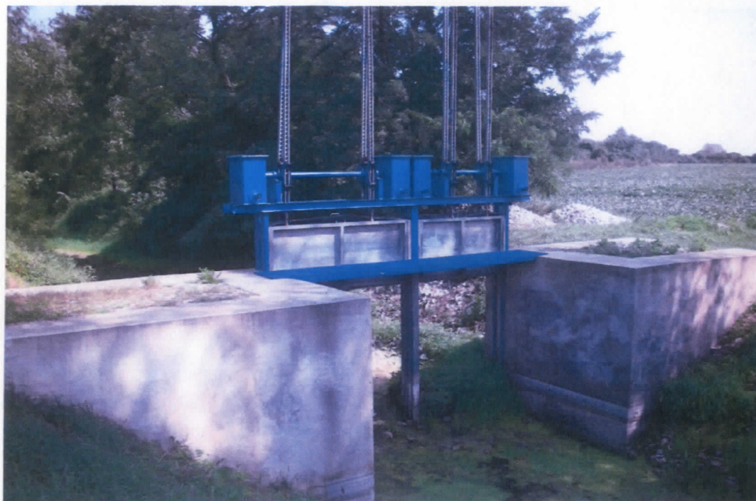
Dąbrocznia - jaz w km 20+840
