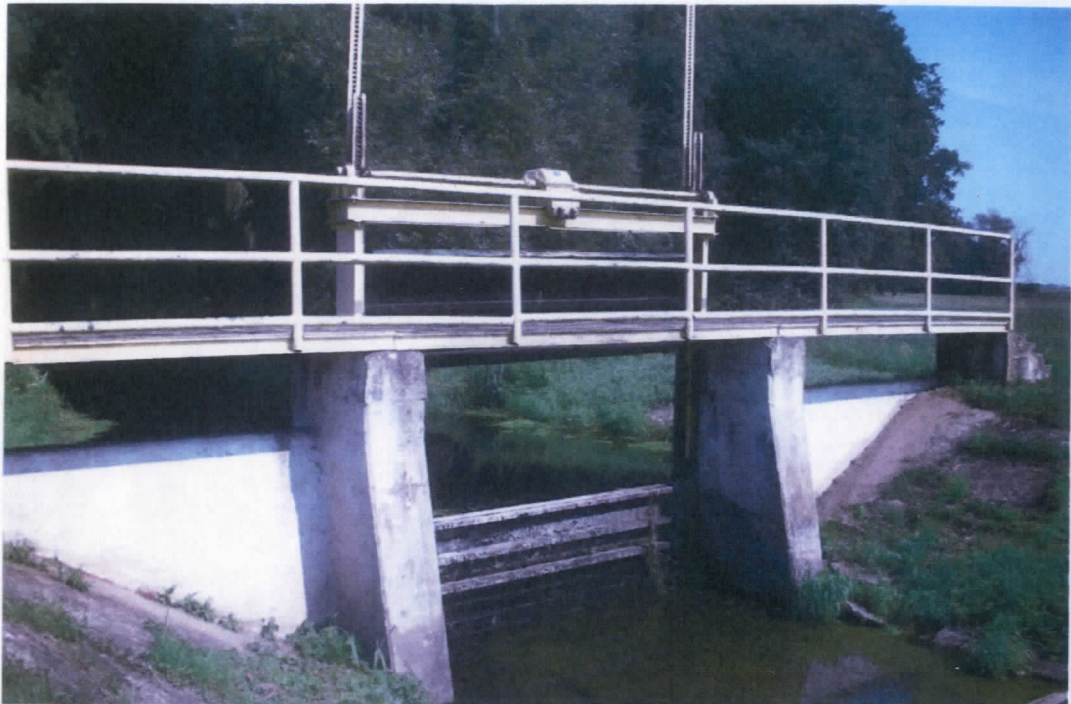
Dąbrocznia - jaz w km 9+100
