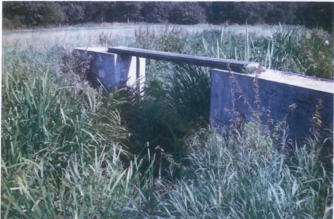
Dąbrocznia - zastawka w km 27+570
