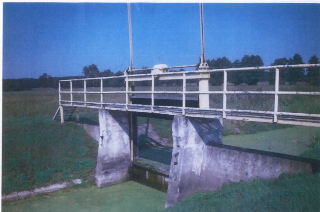
Dąbrocznia - jaz w km 4+270
