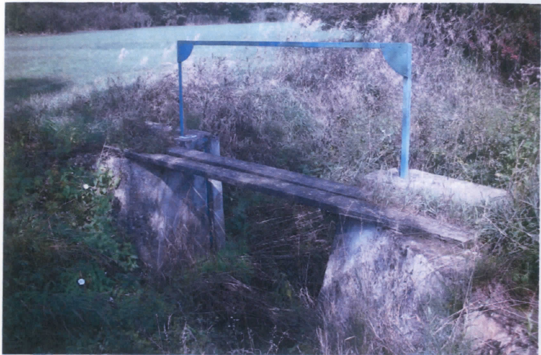
Dąbrocznia - zastawka w km 35+840
